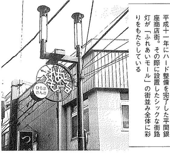
平成十一年にハード整備を完了した平間銀座商店街。その際に設置したシックな街路灯が「ふれあいモール」の街並み全体に彩りをもたらしている
