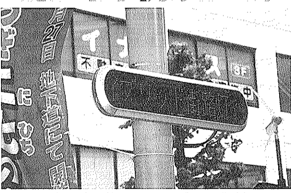
電光掲示板が付いているハイブリッド街路灯
